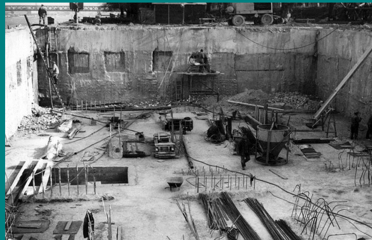
Základ pod pylónom
