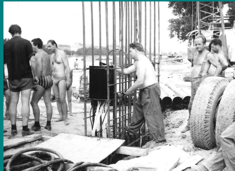
Skúšanie snímačov deformácie a ich osadzovanie do pilót
