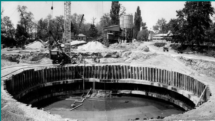
Zakladanie kotevného bloku
