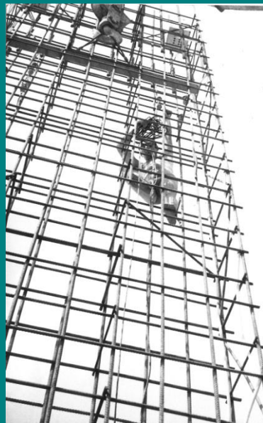
Skúšanie snímačov deformácie a ich osadzovanie do pilót
