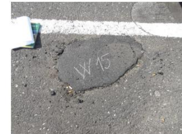
Oprava vozovky označená ako W 15
