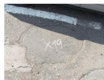
Oprava vozovky označená ako X 19
