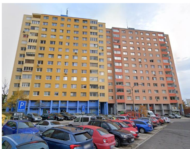
Obr. 1 Pohľad na hodnotený bytový dom [Google]
