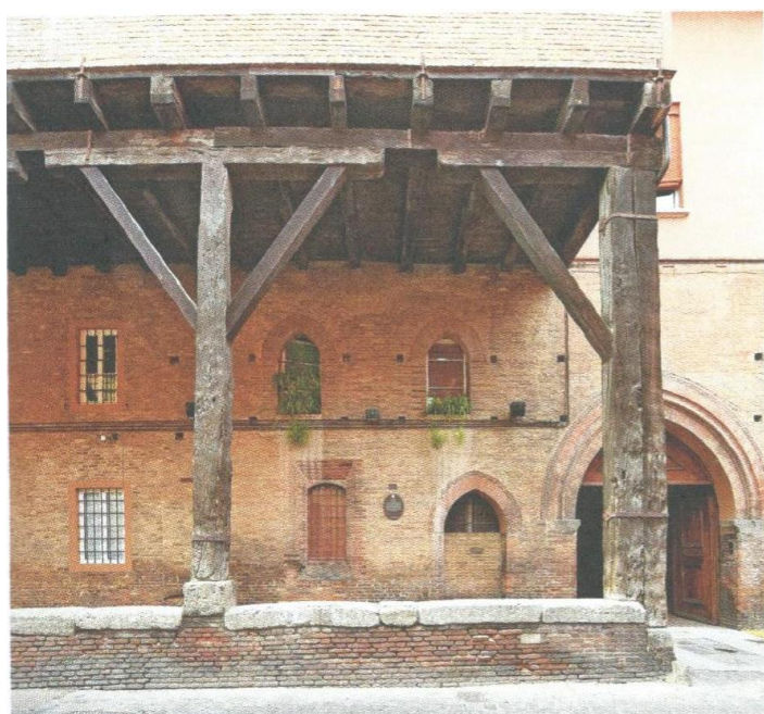
obr. č. 7.: Drevená arkáda v Palazzo Grassi, via Marsala Bologna. Štruktúrally detail "portici" [2]
