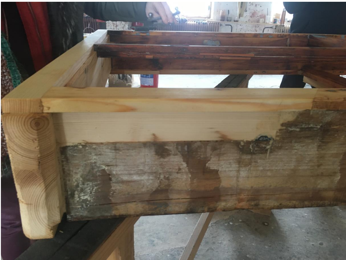
Obr.5: Protéza pôvodného okenného rámu (Zdroj: archív: Reiskupová)
