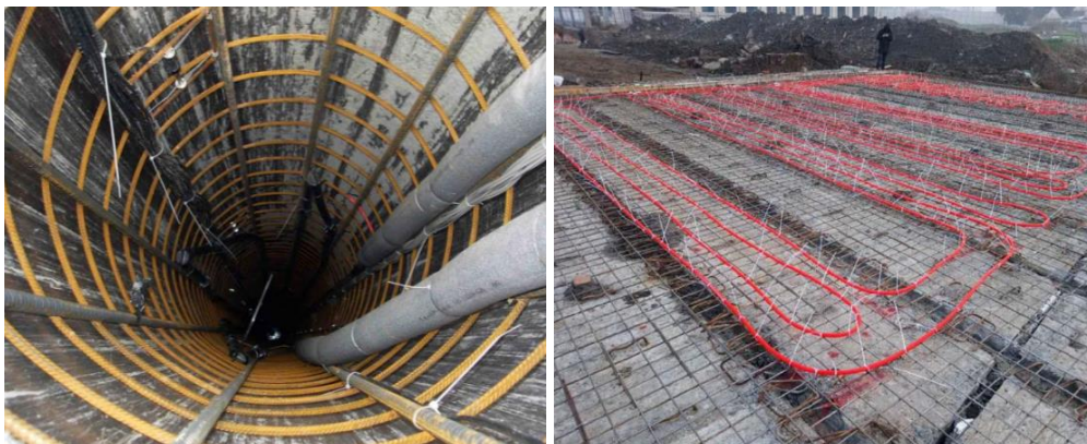
Obrázok 1: Energetické pilóty a energetické dopravné plochy [1].
