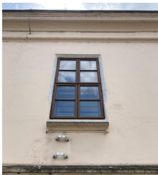
Obr.7: Pohľad na kópiu vonkajšej okennej výplne. (Zdroj: archív Naddourová)
