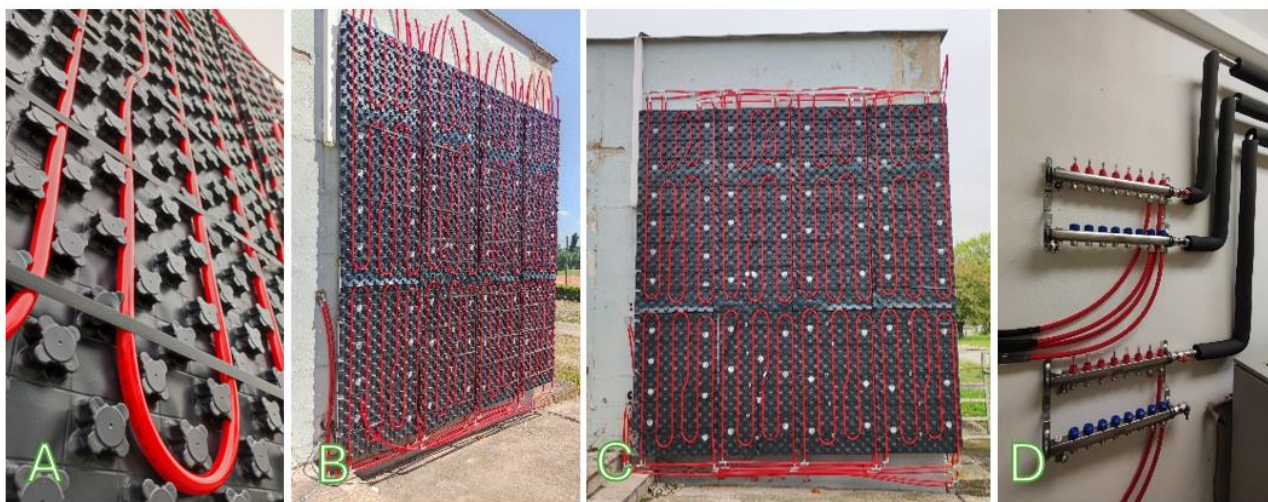
Obrázok 8: Finalizácia fasády objektu s ATO [Autor]
