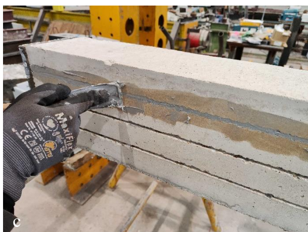
Obr. 2: Fotodokumentácia zo zosilňovania stĺpov, a) drážkovanie, b) lepenie tenzometrov na lamely, c) nanášanie epoxidového lepidla do drážok, d) osádzanie lamiel do drážok
