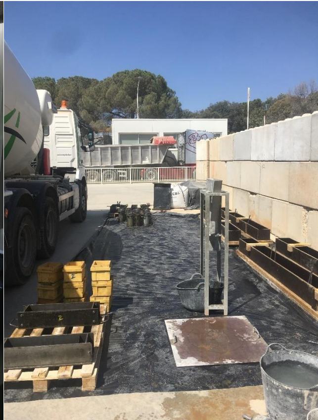
Obrázok 11. Pripravené pracovisko na betonáž
