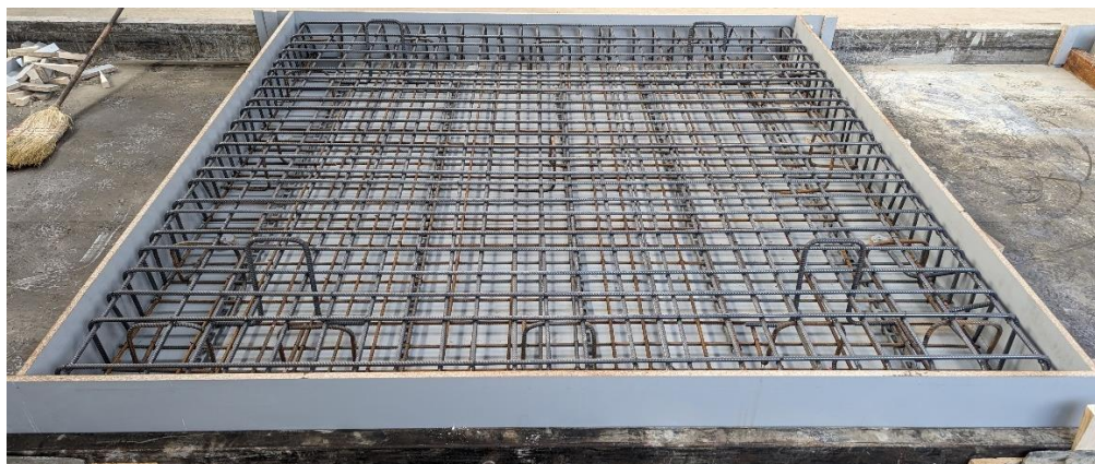
Obr. 2: Pripravená výstuž dosky D1.0 pred betonážou
