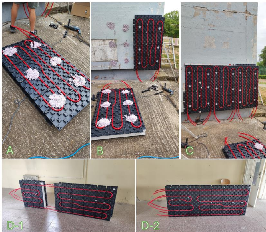
Obrázok 7: Aplikácia panelov ATO na fasádu objektu [Autor]
