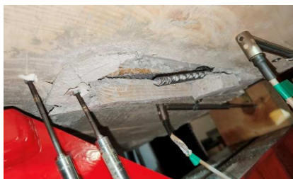
Obr. 25 Vtláčanie výstuže do CLT bloku.
