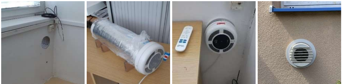
Obrázok 4.1: Inštalácia vetracieho zariadenia do otvoru v obvodovej steny (autor)
