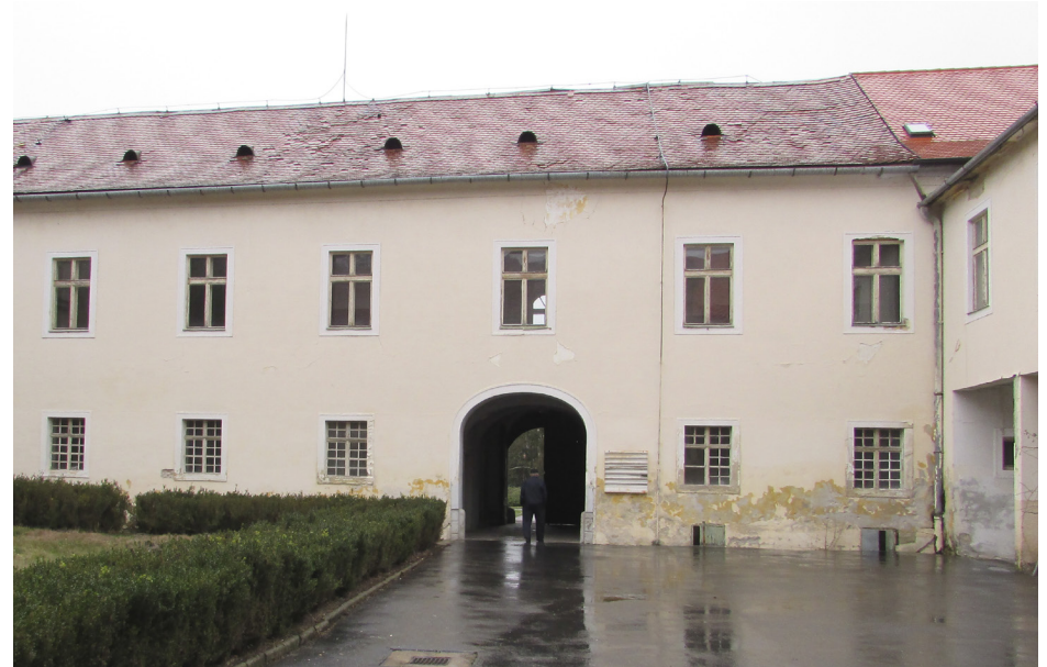
Pohľad na severnú fasádu nádvorja _skutkový stav
