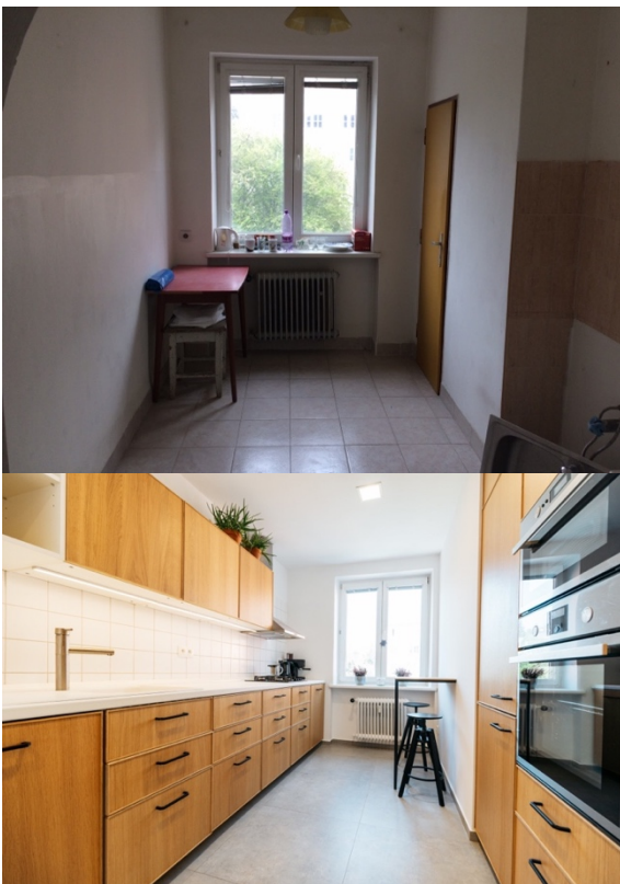
Obrázok 20 Rekonštrukcia bytu (zdroj: Autor)
